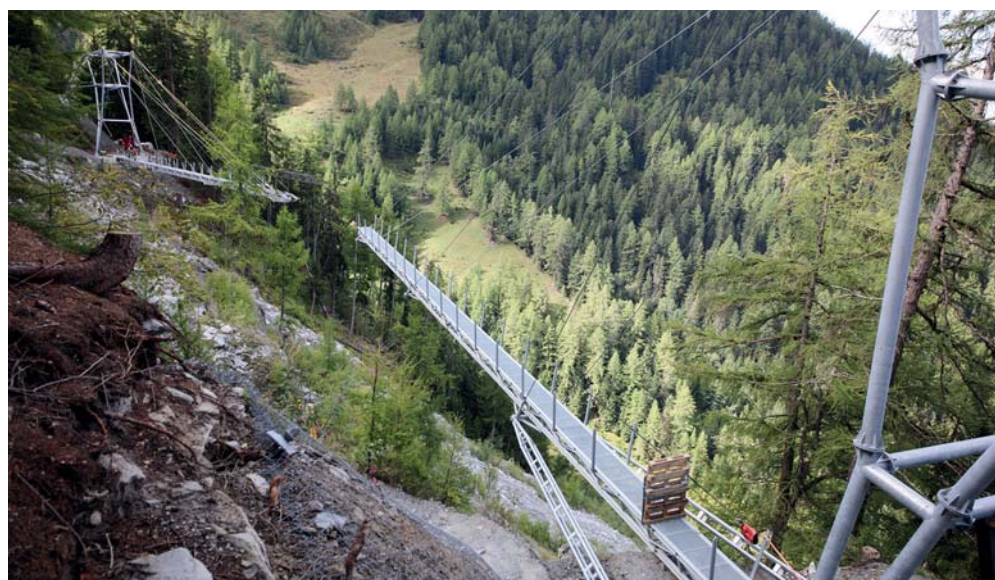
Dorénavant, la promenade sur le bisse de Saxon à la hauteur des Dzoras sera grandement facilitée grâce à cette passerelle qui permet d'éviter l'éboulement. | Photo Guillermin
