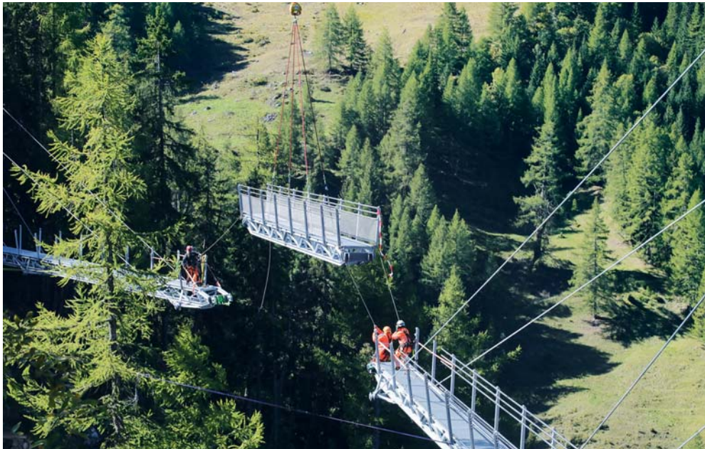
Pose du dernier élément par l'hélicoptère: la grande précision! | Photo Guillermin
