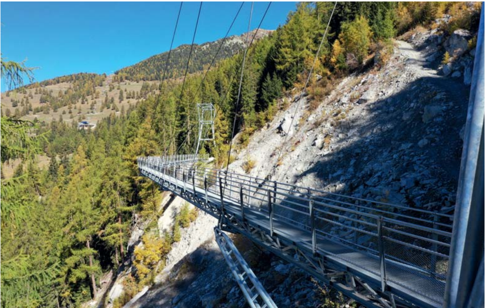
Sur le bisse de Saxon, la passerelle en acier à haubans de 110 mètres de long relie La Tzoumaz à Isérables. | Photo Guillermin
