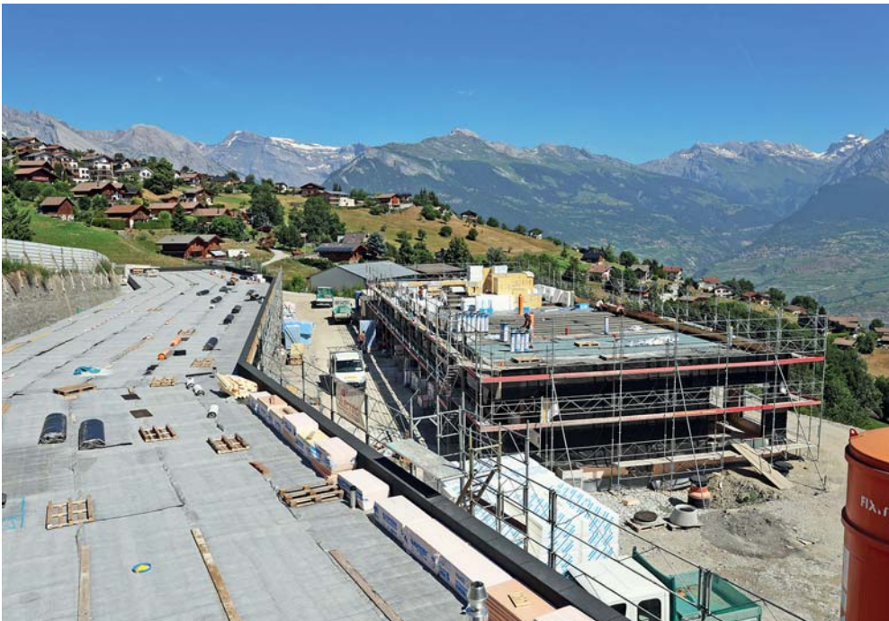
Le chantier des bâtiments des Travaux Publics de la commune de Nendaz avance rapidement. Bientôt la fin des travaux! | Photo Guillermin
