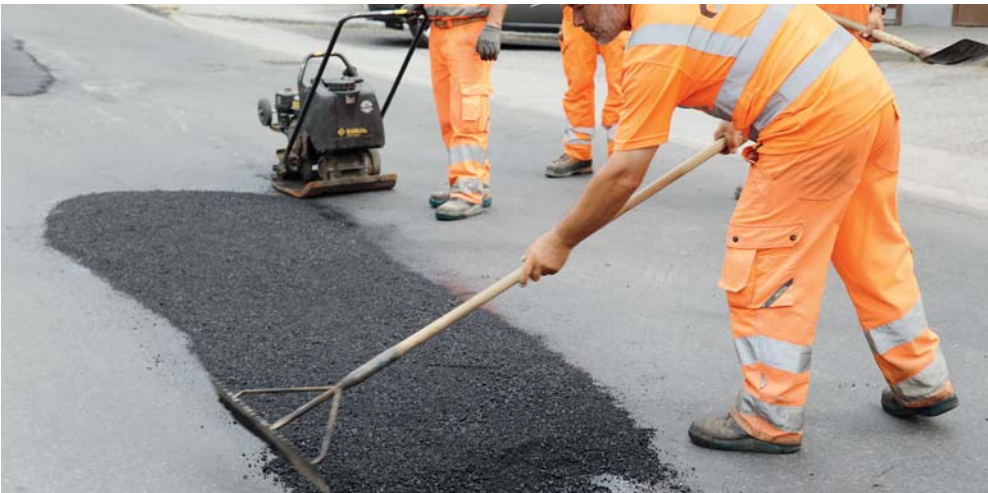
La route de la télécabine ayant souffert depuis plusieurs hivers, des travaux d'entretien ont enfin pu se faire ce mois de juillet pour l'améliorer. | Photo Guillermin
