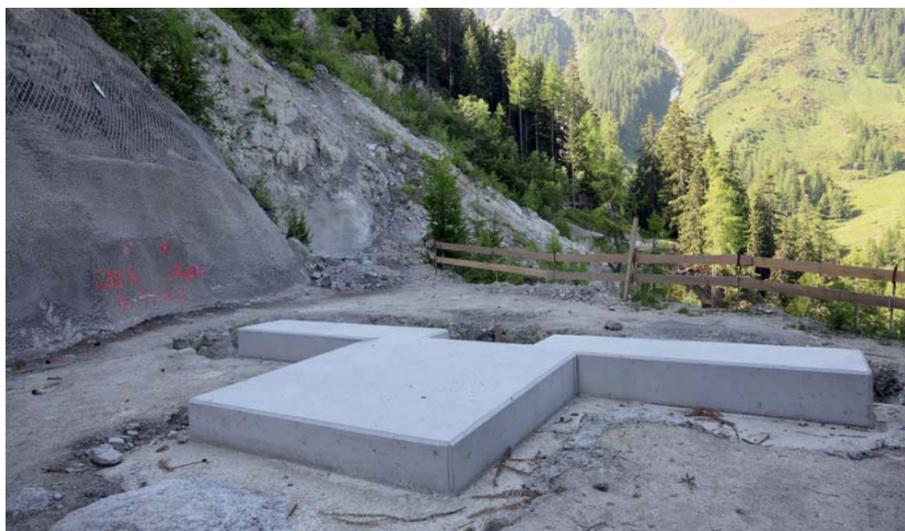
En raison d'un éboulement qui a emporté le bisse de Saxon, une passerelle doit être édiflée afin de rétablir le passage. Sur notre photo, les socles sont déjà en place. | Photo Guillermin
