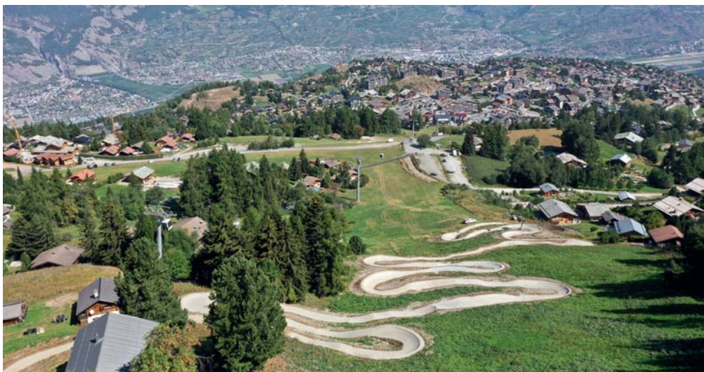
Les travaux de la piste de descente VTT depuis Tracouet touchent à leur fin: ici au niveau du Clou. | Photo Guillermin
