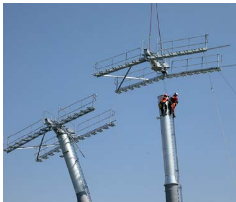
Assemblage des pylônes avec l'aide de l'hélicoptère. | Photo Guillermin
