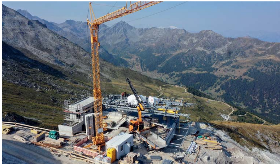
La gare supérieure est bientôt sous toit. | Photo Guillermin
